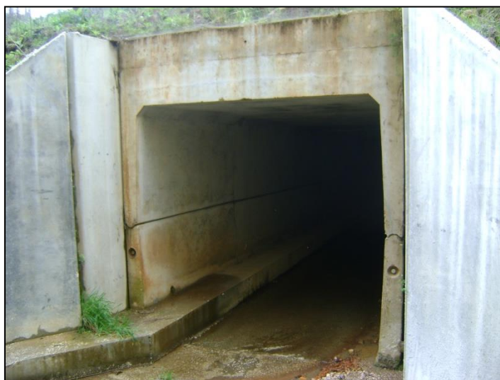
Figura 1 – Ponto de recolha de águas superficiais – PH 5.2 – Montante.
