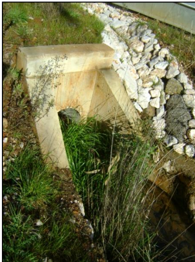
Figura 9 – Ponto de descarga das águas de escorrência da via localizado ao km 1+640.
