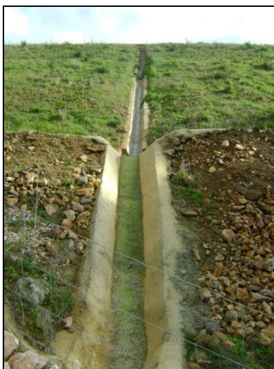
Figura 10 – Ponto de descarga das águas de escorrência da via localizado ao km 5+300.
